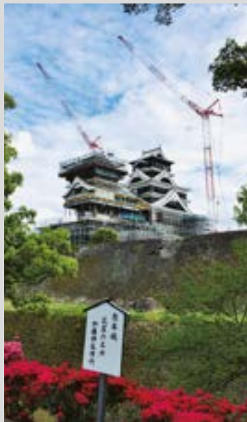
復旧工事中の熊本城。 (私が入学した2019年4月撮影)
